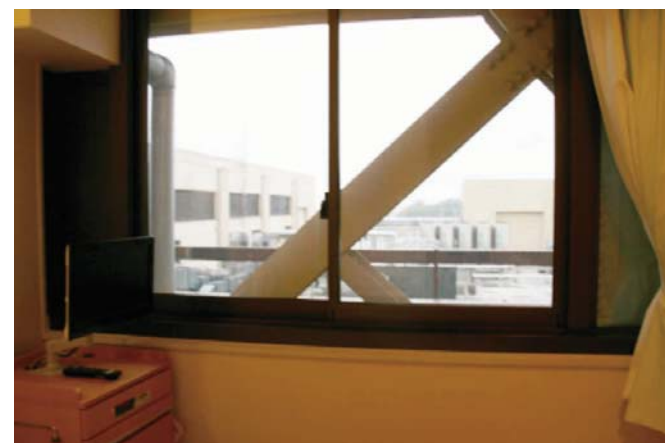
耐震補強の鉄骨により景観が損なわれている
